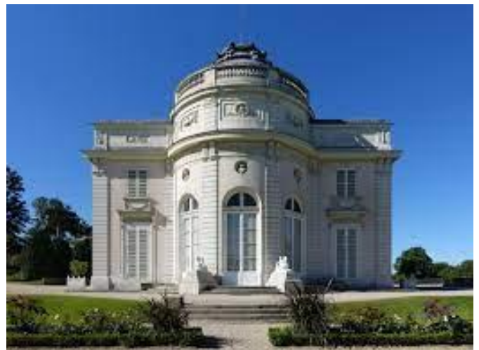
Bagatelle appartient à la Ville de Paris et est en cours de restauration par la Fondation Mansart/Bagatelle.
